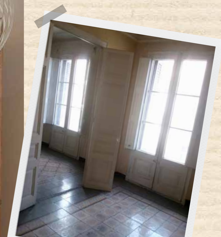
ANTES El salón comedor era un espacio separado por dos puertas de hoja batiente. Dos piezas originales que impedían disfrutar de un espacio con un tamaño adecuado para la familia, al mismo tiempo que reducían el aporte lumínico procedente del exterior.
